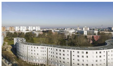
Restructuration du Serpentin à Pantin Agence RVA - ©Luc Boegly - 2014
